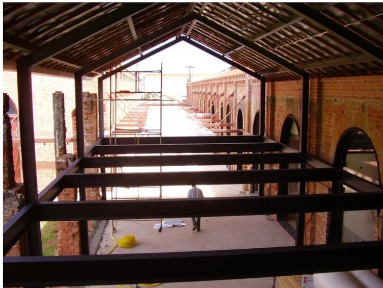
Figura 5.38 – Integração de elementos estruturais originais e contemporâneos. Fonte: Relatório fotográfico de obras. Construtora Esfera. Nov/2006.
