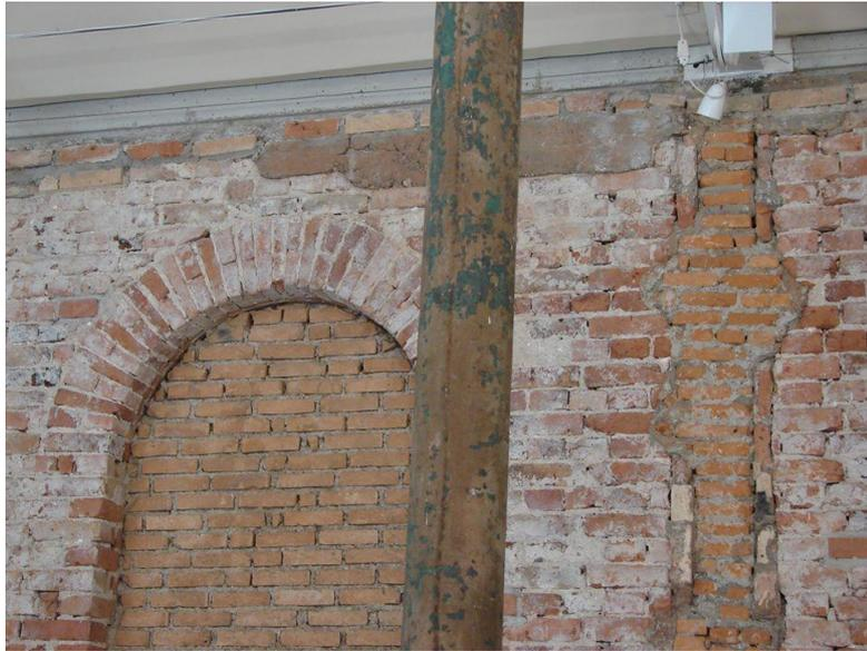
Figura 4.28 – Elementos construtivos e intervenções anteriores preservadas, em favor da memória e do reaproveitamento de materiais. Foto: o próprio autor. 2013.
