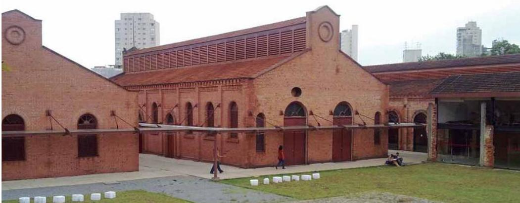
Figura 4.27 – Visão geral dos galpões restaurados, cuja conexão se faz por meio de passarelas cobertas com vidro, atirantadas às alvenarias externas. Foto Google. Fonte: Revista ANICER, Edição 81. Ano VI.
