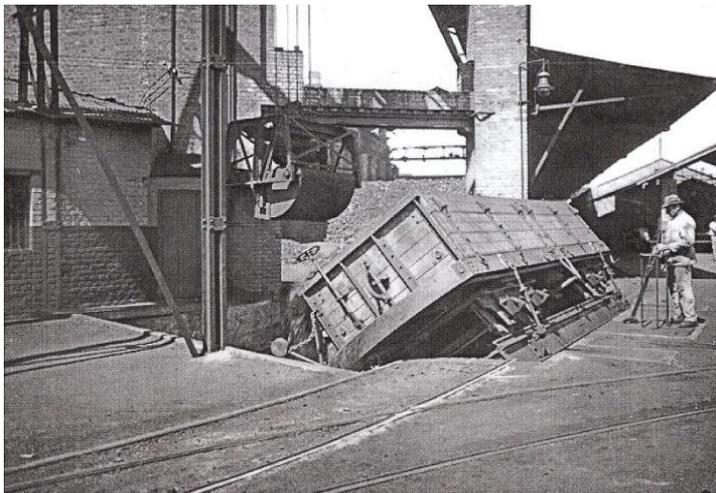
Figura 4.33 – Casa das Retortas – Descarga de um vago de carvão e o sistema elevatório que removia do fosso par o depósito. Fonte: Memorial Básico de Restauro. Arquiteto Paulo Bastos e Associados.
