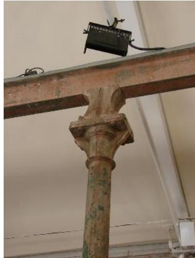
Figura 5.37 – Pilar e viga metálicos preservados. Fonte: o próprio autor. 2013.
