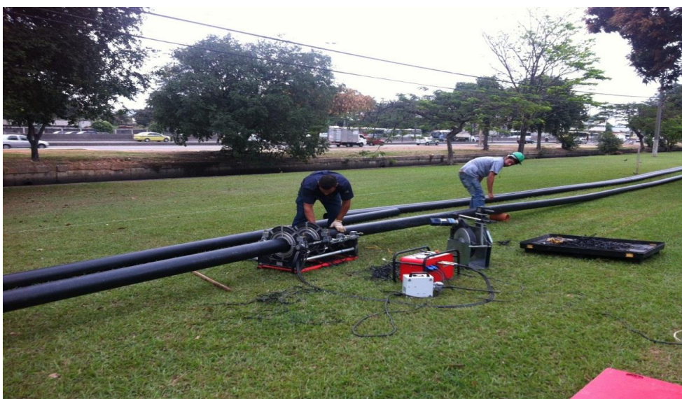
Figura 5.7: Lançamento de tubulações no Complexo Naval da Av. Brasil.
