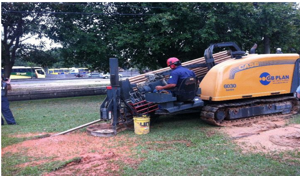
Figura 5.8: Técnica nova de lançamento das tubulações. Fonte: a autora.
