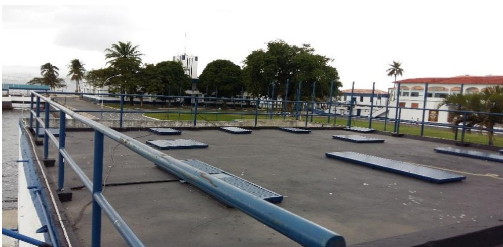
Figura 1.3: Vista Superior da Estação de Tratamento de Esgoto (ETE) do Centro de Instrução Almirante Wandenkolk (CIAW). Fonte: a autora.
