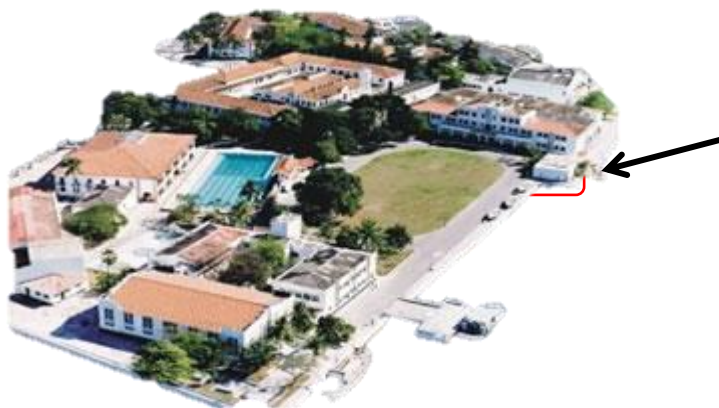
Figura 3.2: Estação de Tratamento de Esgoto. Ilha do CIAW Fonte: a autora.
