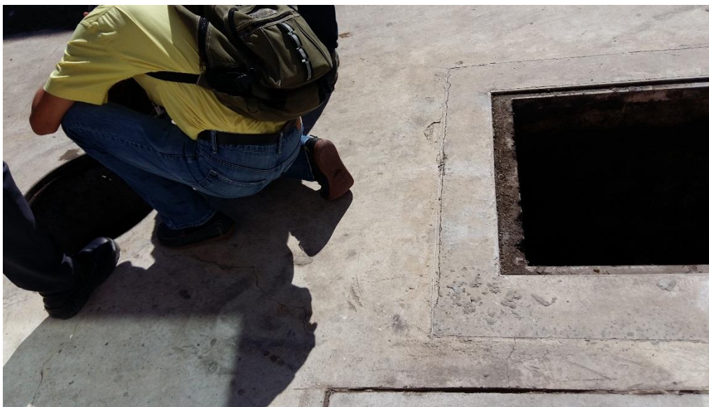
Figura 4.17: Inspeção da Caixa de Gordura da UFEM. Fonte: a autora.
