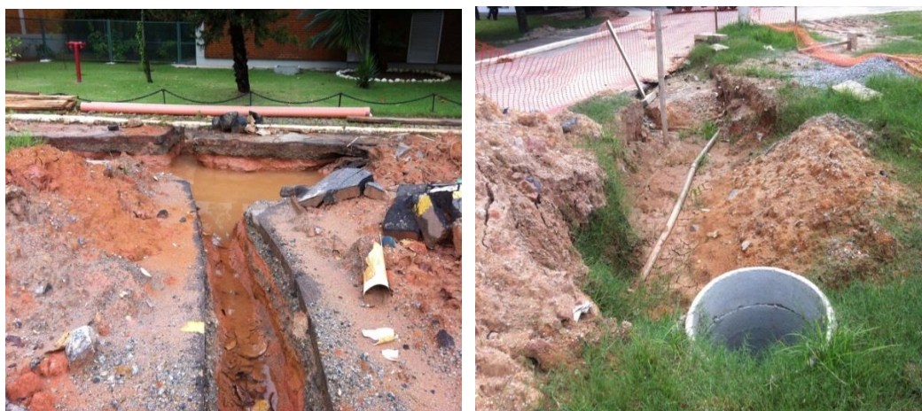
Figura 3.3: Obras de saneamento do Complexo da Avenida Brasil. Fonte: a autora.
