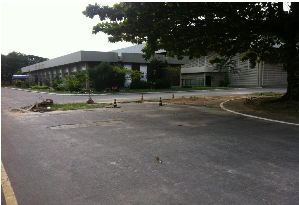
Figura 5.6: Arruamento com obras no Complexo Naval da Av. Brasil. Fonte: a autora.
