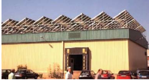
Figura 3: Coletores apoiados em suporte inclinados Fonte: Abrava.
