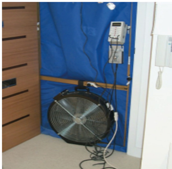
Figura 12 - Teste Blower door Fonte: www.passivhaus.org.uk , 2015
