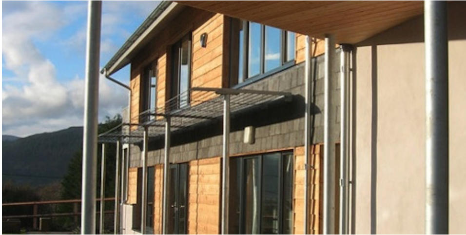
Figura 1 - Construção “Canolfan Hyddgein”, feita pela PWJ Constructions.
