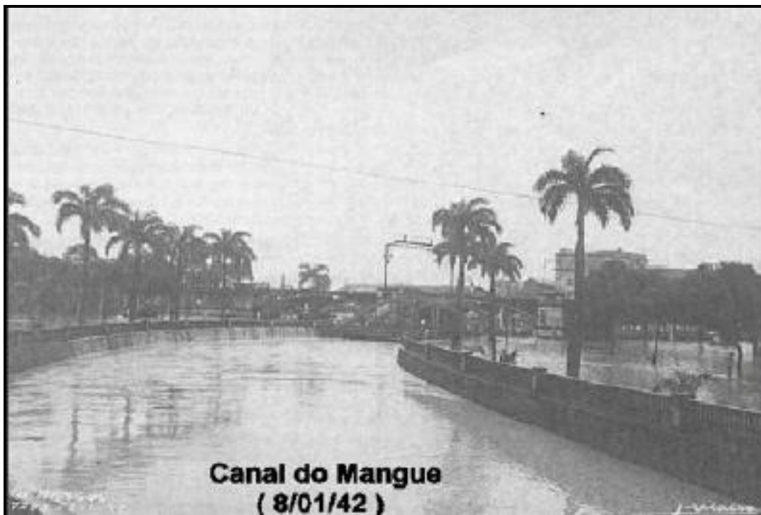
Figura 2 – Enchente no Canal do Mangue em 1942 Fonte: PLANÁGUA/SEMADS/GTZ, 2001.
