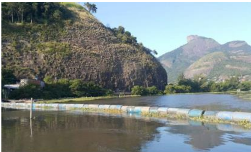
Figura 2.14: Ecobarreira instalada na lagoa da Tijuca após rompimento da anterior. Fonte: Magalhães e Costa (2016).
