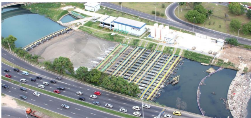
Figura 2.16: UTR Arroio Fundo Fonte: DT Engenharia (2019).
