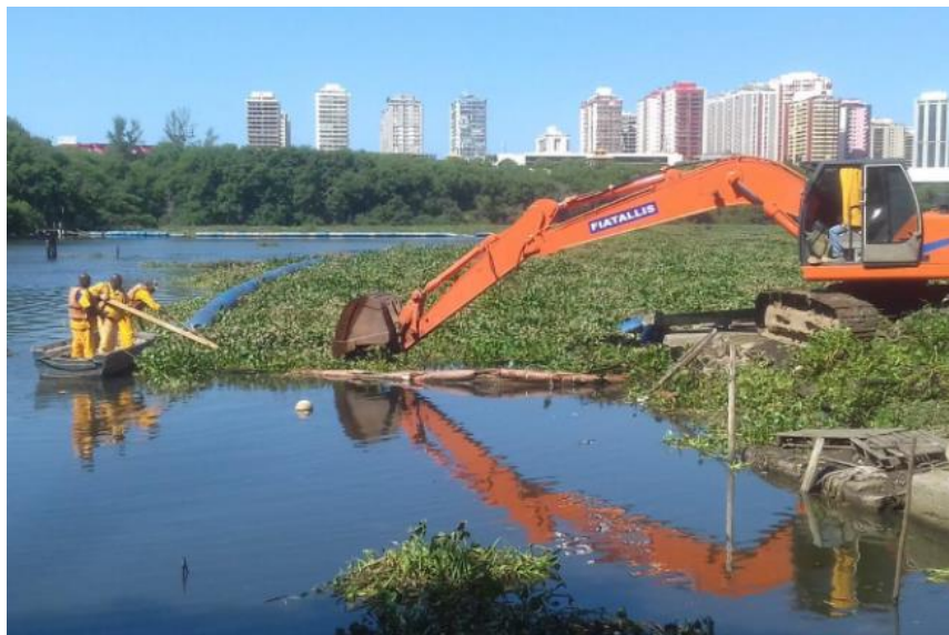
Figura 2.15: Retirada de gigogas com ajuda de escavadeiras. Fonte: INEA (2020).
