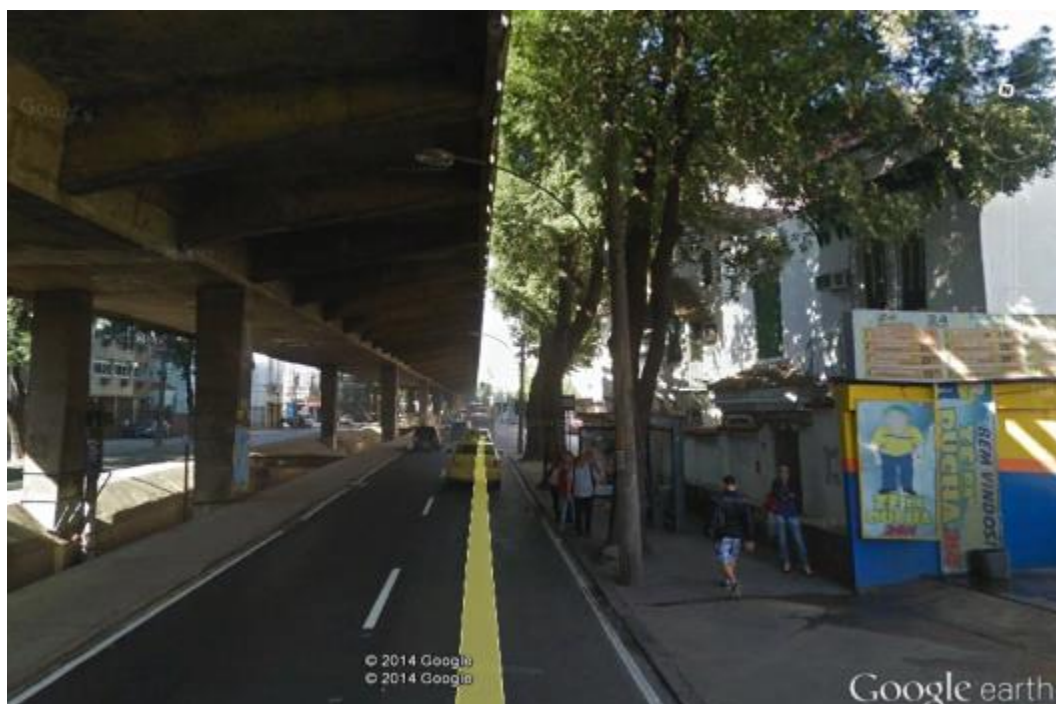
Figura 35 (acima) - Vista da Avenida Paulo de Frontin sob o elevado e no limite com a Praça Condessa Paulo de Frontin. Figura 36 - Vista da Avenida Paulo de Frontin sob o elevado próximo à esquina da Rua Haddock Lobo. 27
