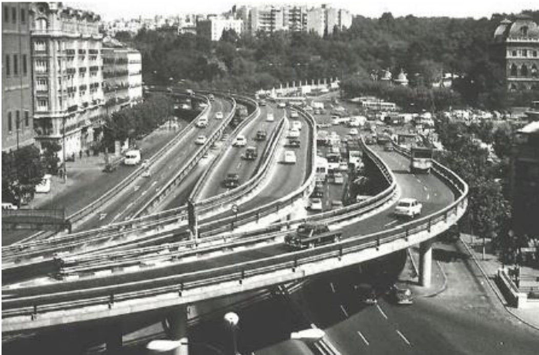
Figura 11 - Antigo viaduto em frente à Estação de Atocha, em Madri (Espanha). 8
