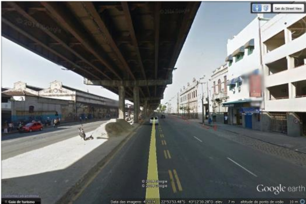
Figura 45 - Vista da Avenida Rodrigues Alves, na região da rodoviária, sob o Elevado da Perimetral. 31
