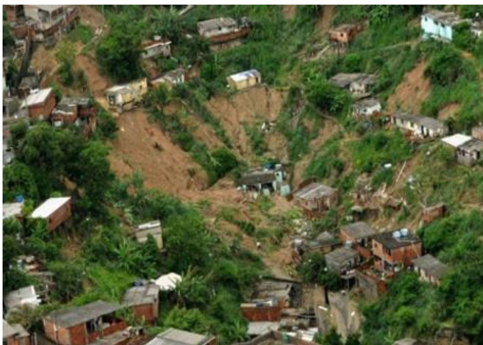
Figura 25: Deslizamento em área de ocupação irregular em Niterói.
