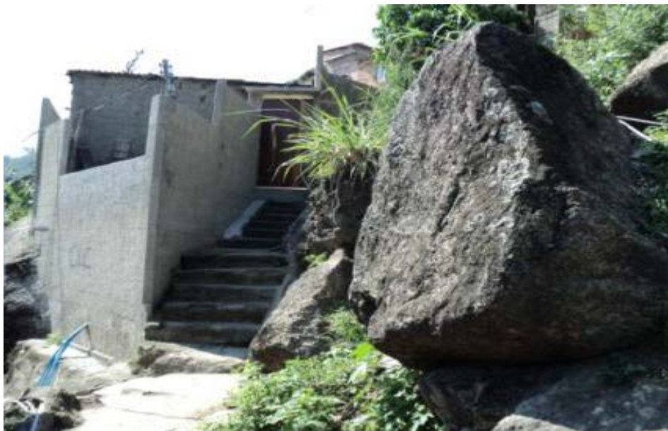
Foto 20 – Ocupação sobre terreno rochoso com possibilidade de deslizamento em 2011. Fonte: Ampla.
