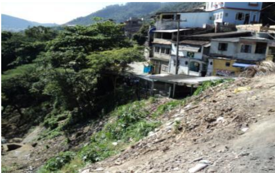
Foto 19 – Encosta no morro do Preventório em 2011. Fonte: Ampla.
