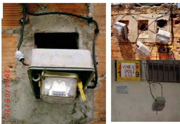
Foto 10 – Medidores com eixos deslocados. Ano: 2004.
