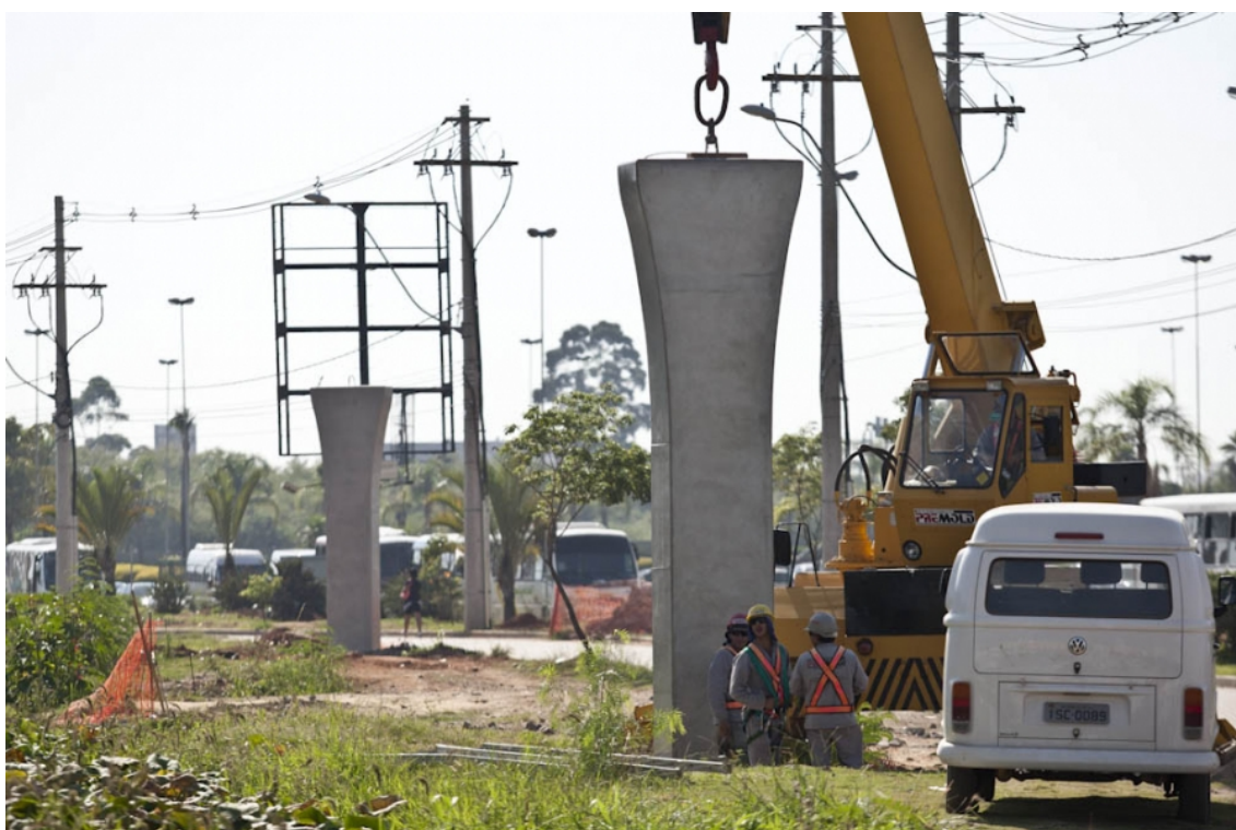
Figura 15 – Pilares pré-moldados de concreto armado da via elevada (Coester, 2012).
