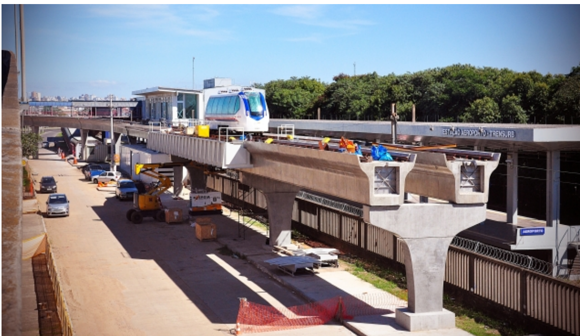
Figura 16 – Vigas pré-moldadas de concreto armado da via elevada (Coester, 2013).
