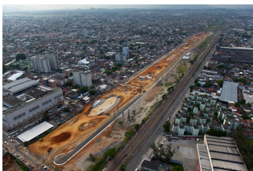
Figura 43 - Vista aérea do Parque Madureira em obras. Fonte: http://amadavi.blogspot.com.br
