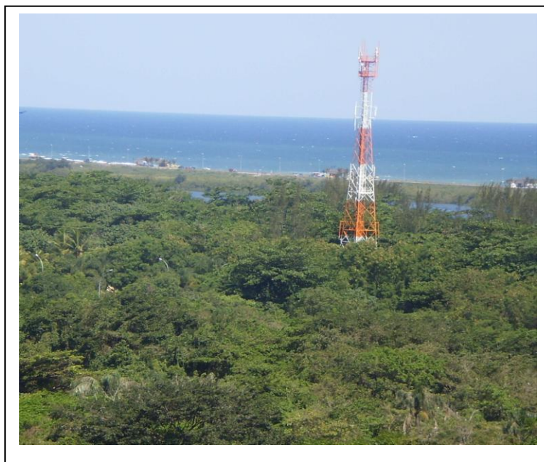
Figura 27 – Antena de Telefonia Celular dentro do Parque Marapendi ( no final da Rua Prof. Alfredo Colombo) – Rio de Janeiro /RJ
