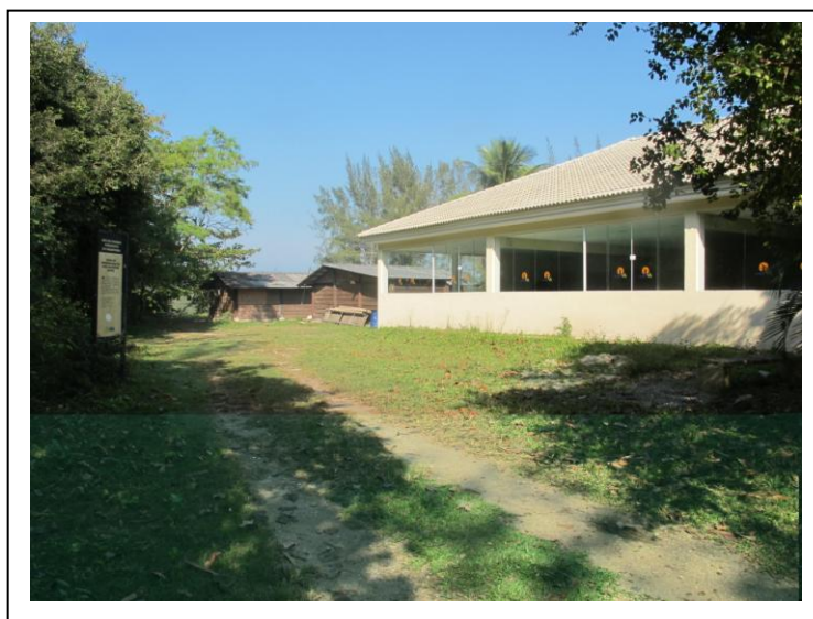
Figura 30 – Construção irregular na área do Clube Ginástico Português (atrás do Condomínio Barra Bali) – Rio de Janeiro /RJ
