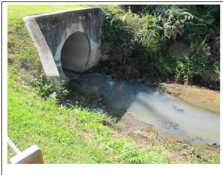
Figura 24 – Lançamento de esgoto na Lagoa de Marapendi através da rede de águas pluviais (final da Av. Moysés Castello Branco Fº, ao lado do Condomínio Malibu) – Rio de Janeiro /RJ
