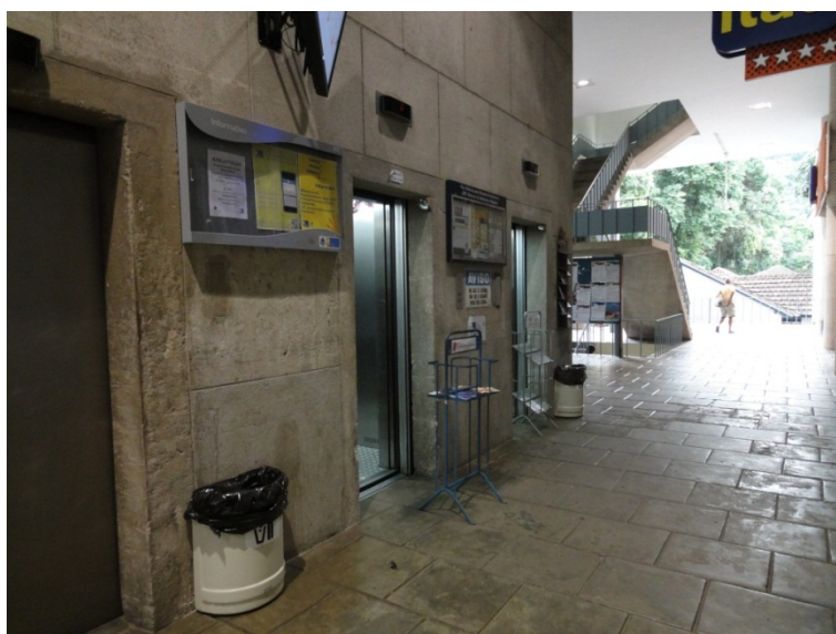
Figura 182 – Coletores antigos de resto no Térreo - Edifício Amizade
