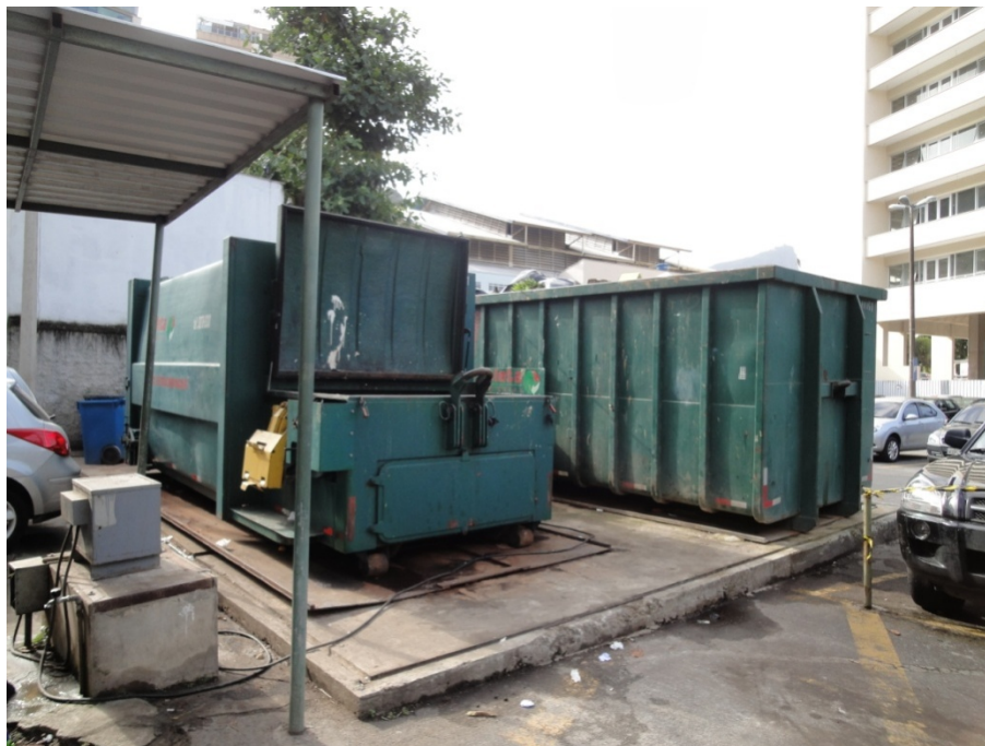
Figura 16 – Compactadora de 20m 3 localizada no Campus da PUC-Rio
