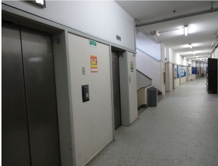
Figura 109 – Coletor seletivo de resto no 2º pavimento – Bloco C
