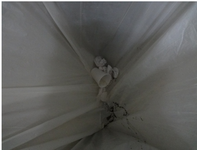
Figura 124 – Coletor seletivo de resto no 5º pavimento – Bloco C
