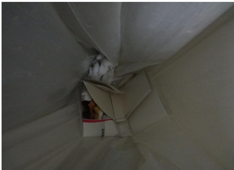
Figura 102 – Coletor seletivo de resto no 1º pavimento – Bloco A
