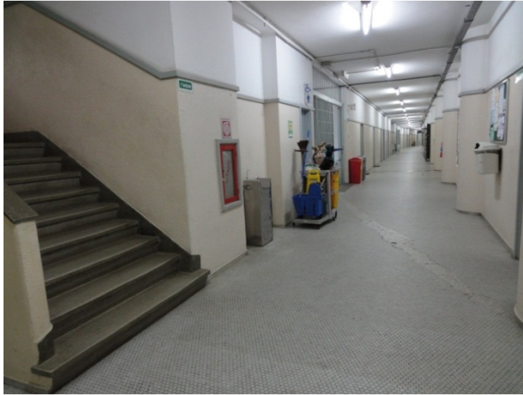
Figura 101 - Coletor antigo no 1º pavimento – Bloco A
