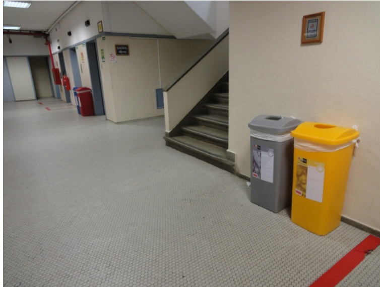
Figura 184 – Conjunto de coletores seletivos no 1º pavimento da Ala Frings - Edifício Amizade
