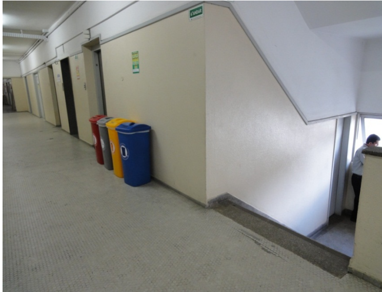
Figura 127 – Coletores seletivos no 6º pavimento – Bloco E
