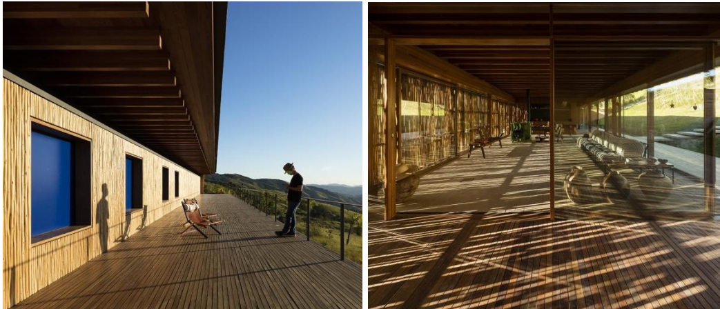
Figura 50 e Figura 51: Fachada norte revestida em eucalipto, também utilizado como brise para filtrar luz e calor externos e proporcionar conforto térmico no interior da edificação. Fonte: Studio MK2 (2016); Reis (2019).
