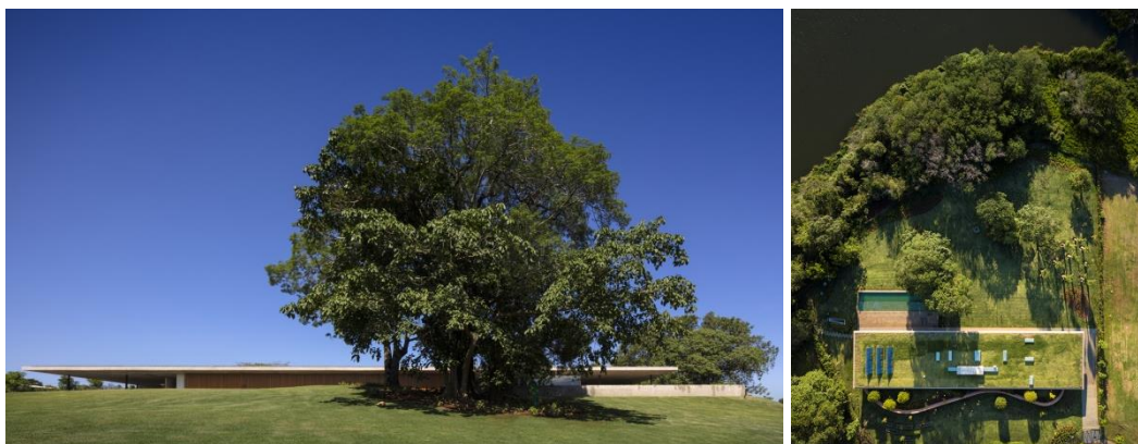
Figura 52 e Figura 53: Vistas panorâmica e aérea da Planar House – baixo impacto visual de sua implantação. Fonte: Studio MK27 (2018).
