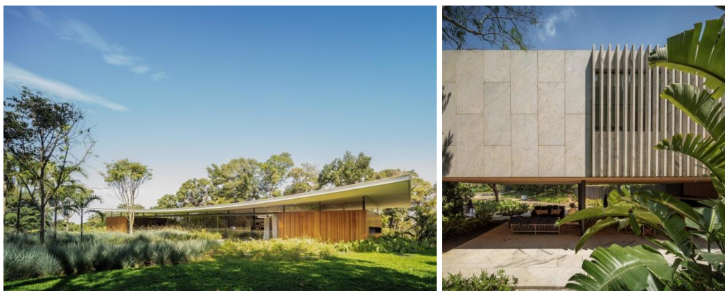
Figura 42 e Figura 43: Casa Asa – Integração com paisagismo, embasamento em pilotis e detalhe para elementos de sombreamento na fachada. Fonte: Bernardes Arquitetura (2019).
