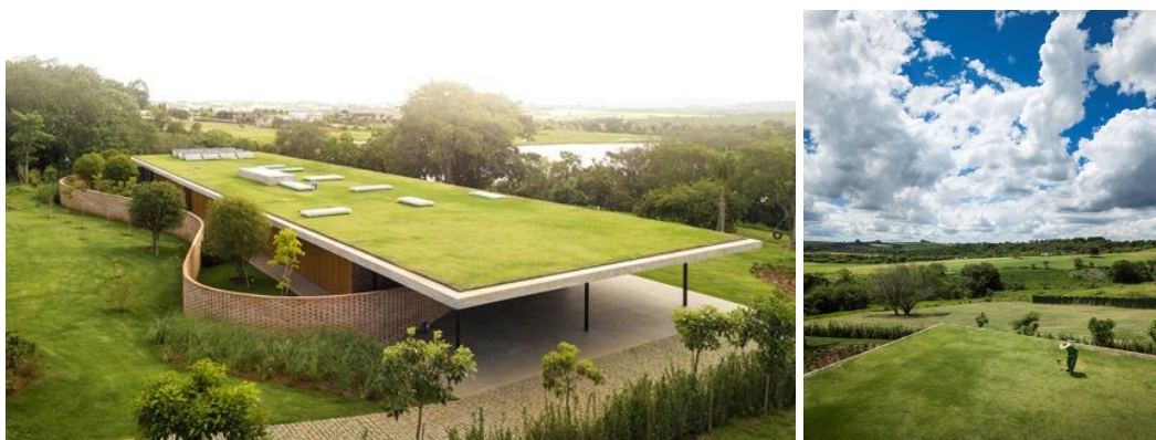
Figura 54 e Figura 55: Laje plana gramada que camufla a edificação no entorno e reduz a absorção térmica provocada pela insolação. Fonte: Studio MK27 (2018).
