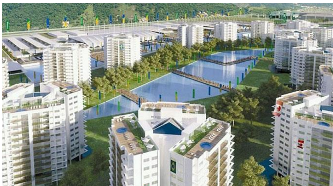
Figura 3 – Edifícios da Vila dos Atletas – Barra da Tijuca - Qualificação Qualiverde
