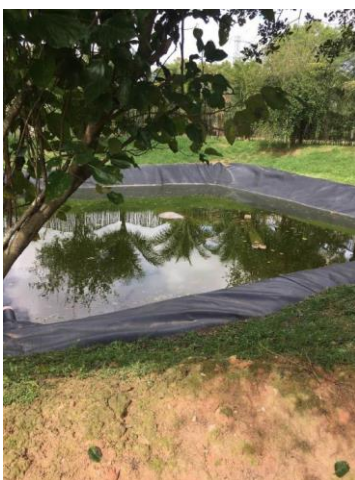
Figura 29 – Lagoa de acumulação de chorume drenado do lixão de Santa Cruz. A lagoa mantém o material que não é retido nas cisternas.
