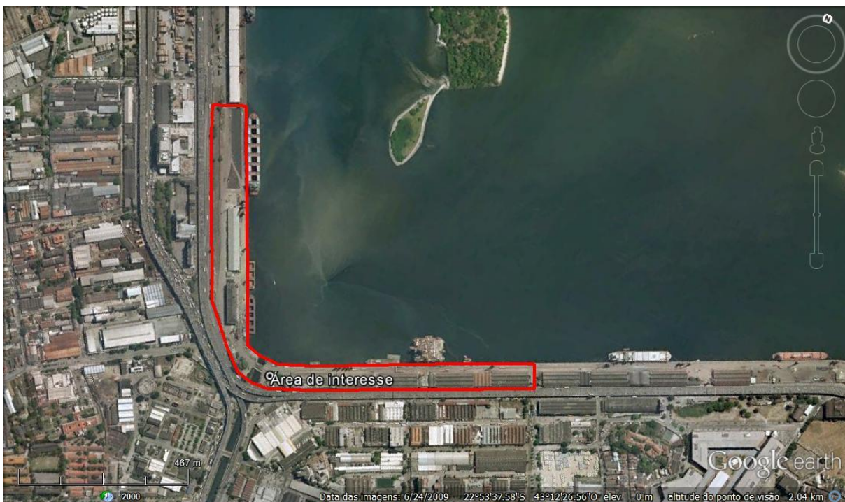
Figura 36: Foto aérea do pátio da Petrobrás na zona de embarque e desembarque do porto do Rio de Janeiro – RJ
