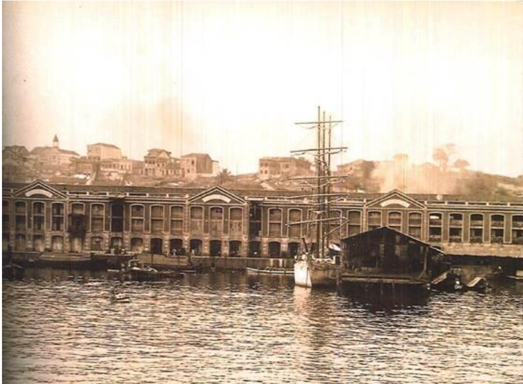
Figura 12: Armazém Docas Don Pedro II, utilizado para o armazenamento de grãos em geral; localizado no cais da Gamboa, Rio de Janeiro. Fonte: Porto Maravilha
