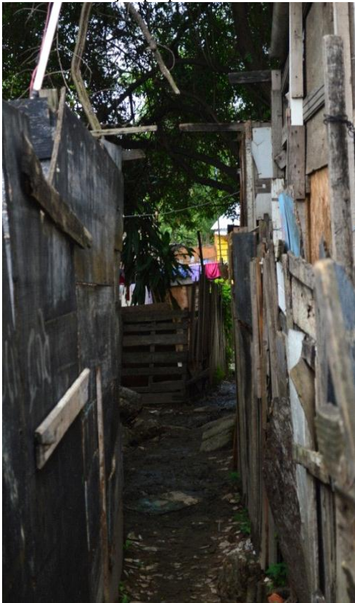
Foto 13: Área 3. Beco 02. Área de circulação onde observa-se a estreiteza das fachadas.
