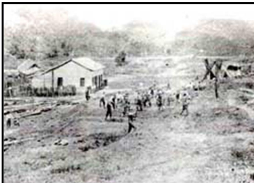
Figura 4 - Núcleo Mauá - Instalação da Colônia. Fonte: Rocha, 1984, disponível em http://www2.uol.com.br/guiamaua/historia/ . Acesso em 02/01/2017.
