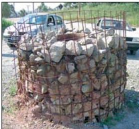
Figura 39 – Dreno típico de aterros, que pode ser adaptado e inserido no sistema de captação de biogás. Fonte: Acervo CENBIO.
