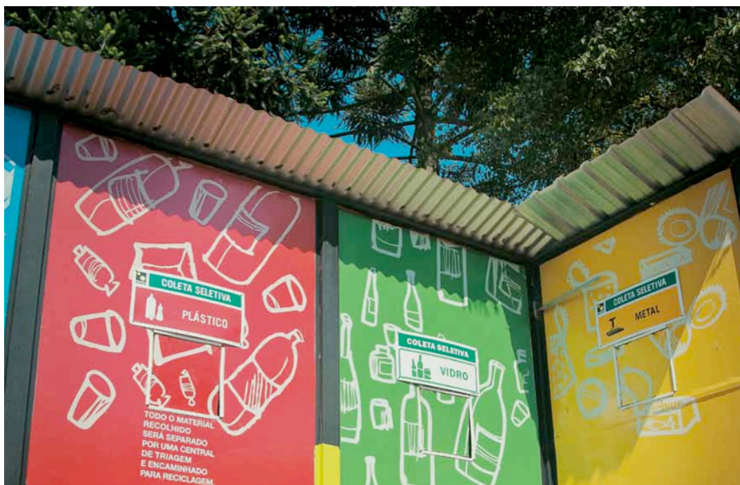
Figura 3.9 – Exemplo de tapume de obras com coleta seletiva;
