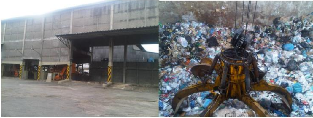
Figura 71 – Foto I - Etapas do processo na Usina do Caju: fachada frontal: entrada dos fossos e garra coletora dentro do fosso.
