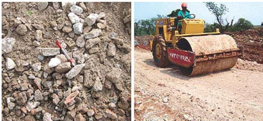
Figura 5.8 – Pavimentação utilizando agregado reciclado (Depto Engenharia de Transporte da USP).
