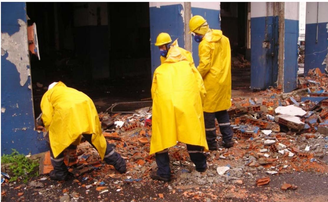
Figura 3.2 – Retirada da alvenaria para preparação da implosão (Arcoenge)
