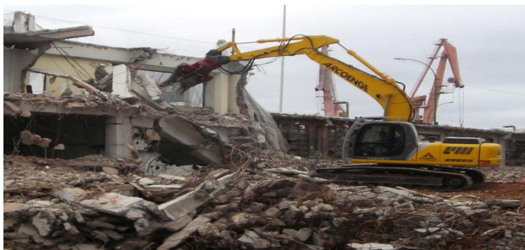
Figura 3.5 – Equipamento pulverizando a estrutura para separação da ferragem (Arcoenge)
