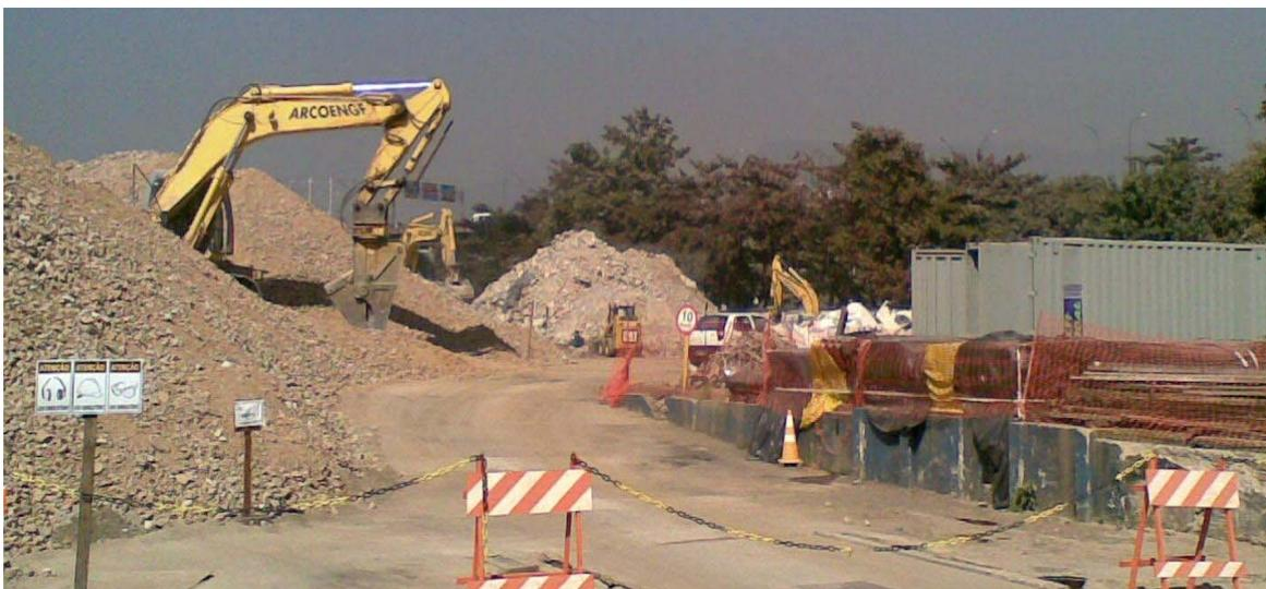
Figura 3.10 – Agregado reciclado aguardando utilização.
