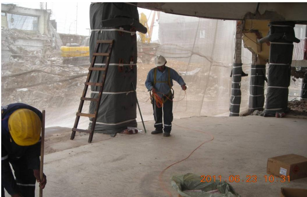
Figura 3.3 – Colocação dos explosivos nos pilares (Arcoenge)
