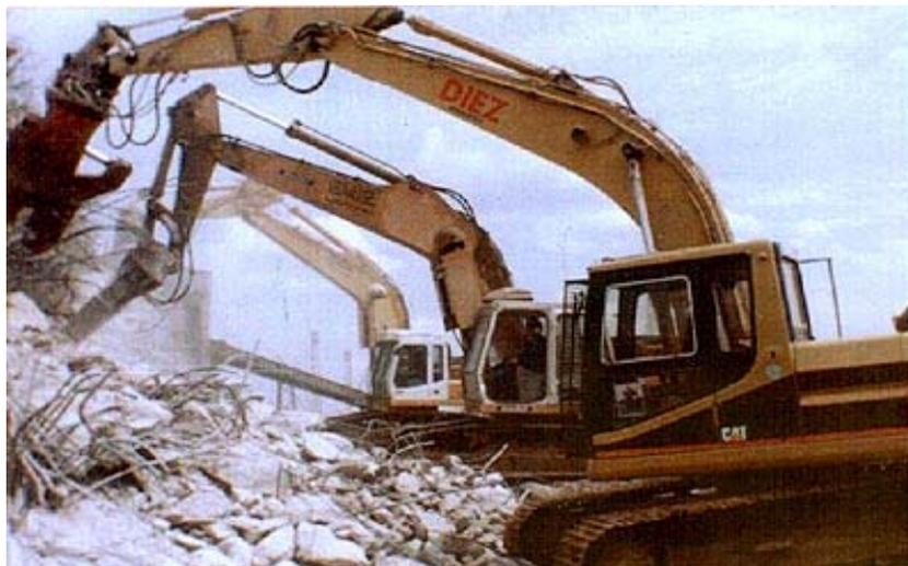
Figura 3.4 – Marteletos demolindo elementos estruturais remanescentes da implosão (Arcoenge)
