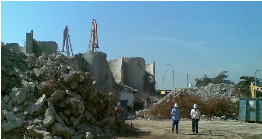
Figura 3.6 – Material segregado por etapas no canteiro de obras.
