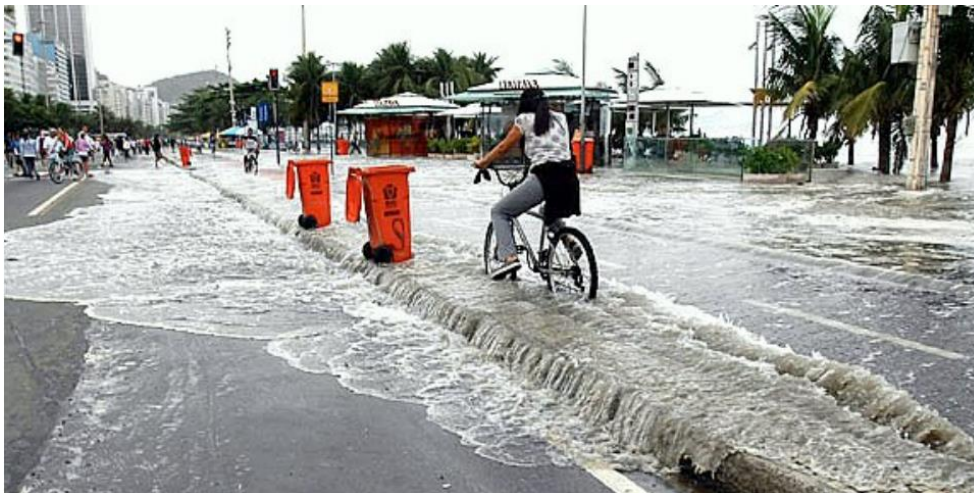
Figura 16 - Onda superando a cota da crista da orla, e alcançando as instalações públicas do calçadão da orla do Leme-Copacabana.
