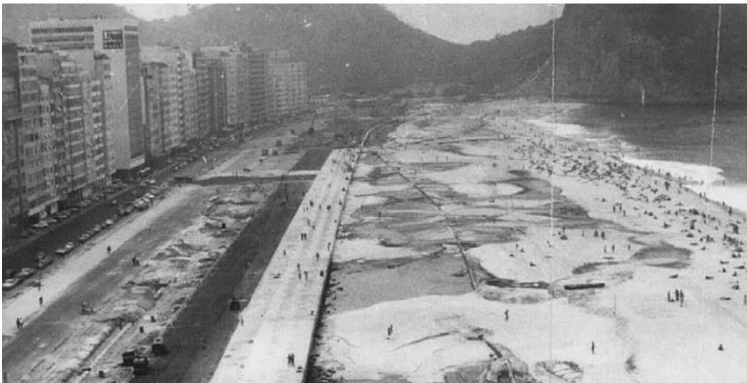
Figura 37 - Registro fotográfico da orla em 1970. Durante as obras de aterro hidráulico.
