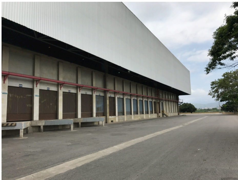
Figura 17. Área de circulação e docas do condomínio Logístico. Fonte: Arquivo do Autor.
