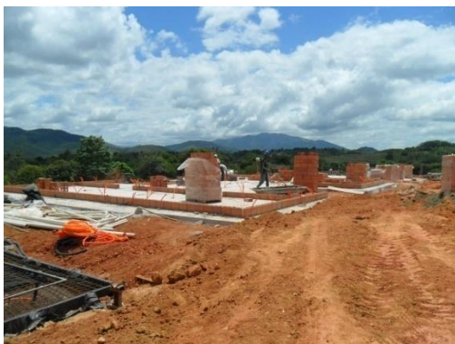
Figura 5.8 – Colocação da 1ª fiada e pavimento aguardando laje.
