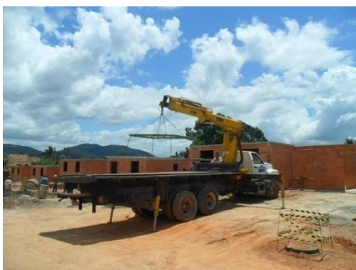
Figura 5.9 – Içamento de lajes e alvenaria pronta para receber revestimento.
