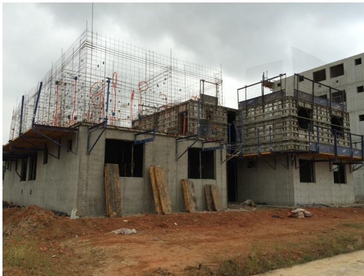
Figura 5.5 – Execução simultânea dos serviços.
