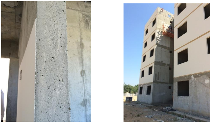
Figura 5.7 – Eliminação da camada de revestimento interna e externa.
