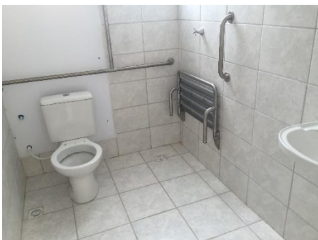
Figura 2.13 – Banheiro com acessibilidade para PNE.
