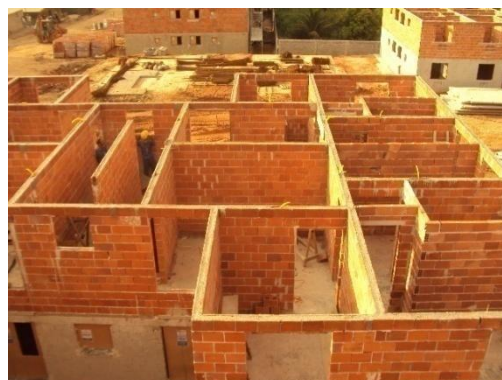
Figura 5.8 – Colocação da 1ª fiada e pavimento aguardando laje.
