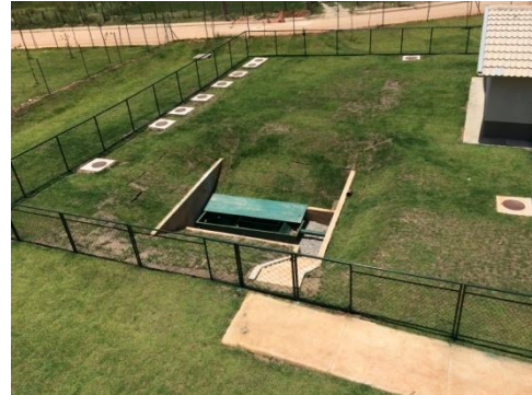
Figura 2.14 – Estação de tratamento de esgoto.
