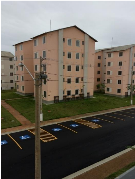
Figura 2.12 – Pavimentação e iluminação pública.
