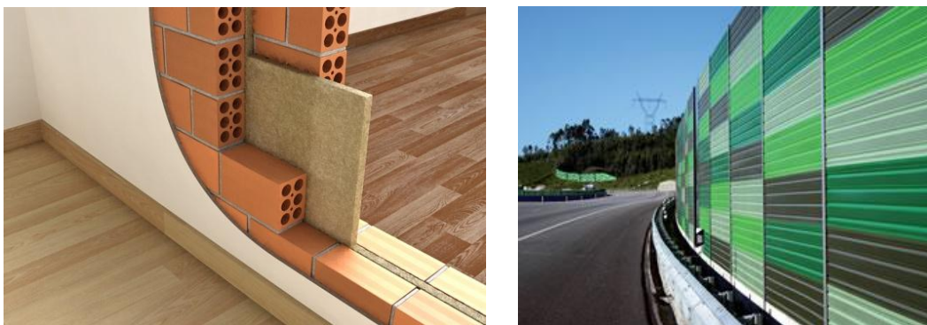
Figura 3.11 – Exemplos de proteção acústica.
