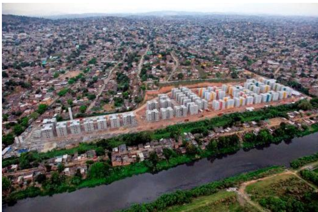
Figura 2.10 – Condomínio Trio de Ouro no Município de Belford Roxo.
