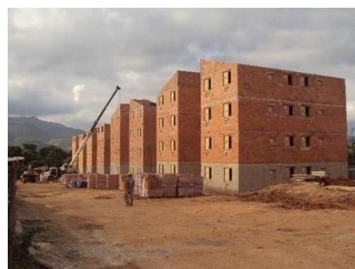
Figura 5.9 – Içamento de lajes e alvenaria pronta para receber revestimento.
