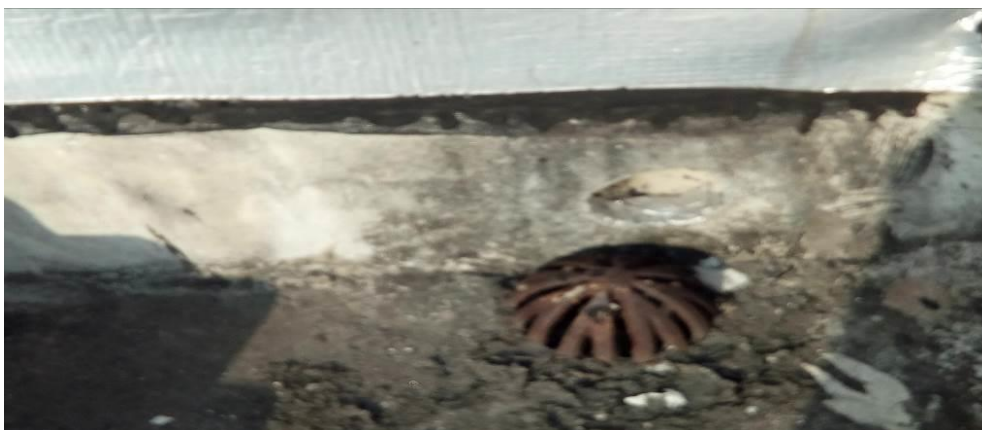
Foto 8 - Ralo do telhado – Park Riviera da Costa
