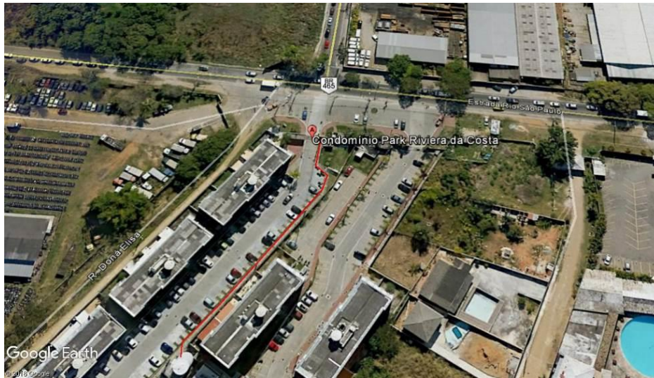
Figura 41 - Tubulação de adução
