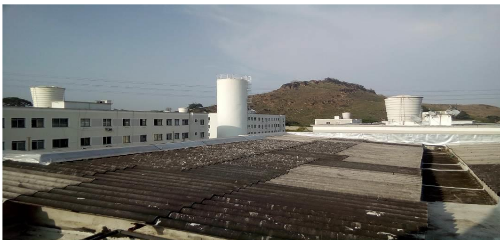
Foto 2 - Detalhe do Telhado – Park Riviera da Costa.
