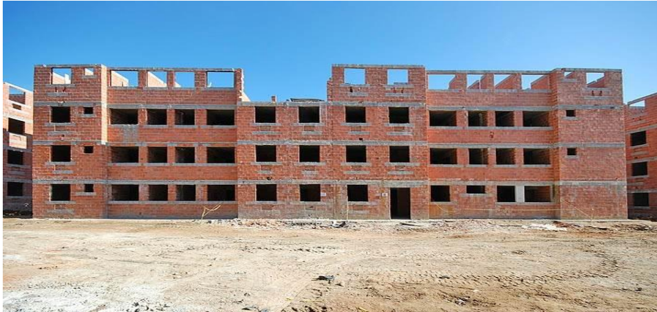
Foto 1 - Alvenaria estrutural – Park Riviera da Costa.
