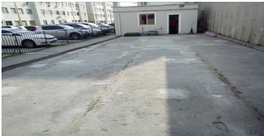
Foto 4 - Cisterna – Park Riviera da Costa
