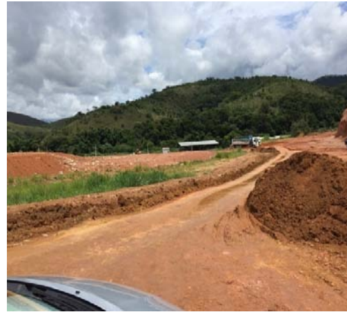
Vista do Aterro Fonte: Concessionária. Jan/17.
