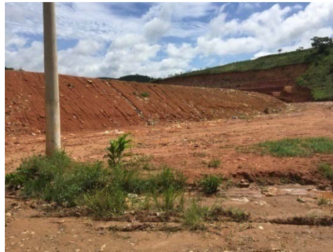
Vista do Aterro Fonte: Concessionária. Jan/17.
