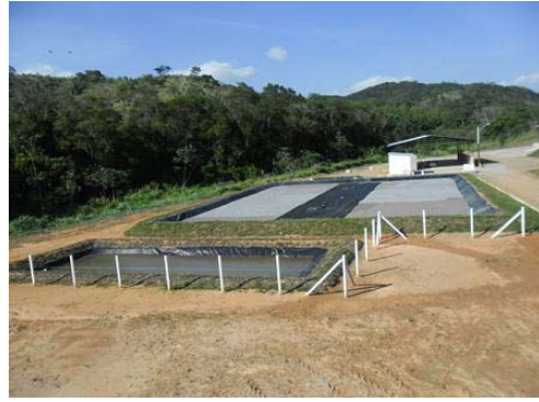
Vista da ETE Fonte: Consórcio N/I. Relatório nov/2012.
