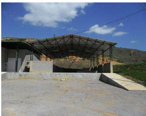
Vista do galpão.
