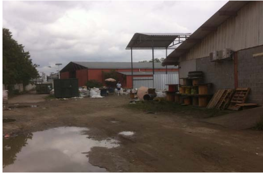
Figura 8 – Vista de dois galpões, 27/09/16. Foto: Aatoria própria.
