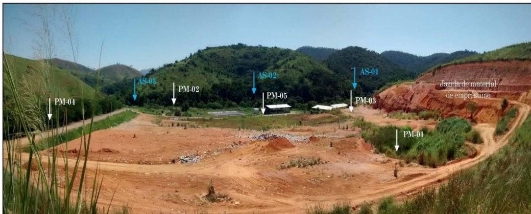
Figura 17 - Vista panorâmica do Aterro Sanitário com indicação dos poços de monitoramento (PM), pontos de coleta de água superficial (AS) e jazida de material de empréstimo para cobertura dos resíduos.
