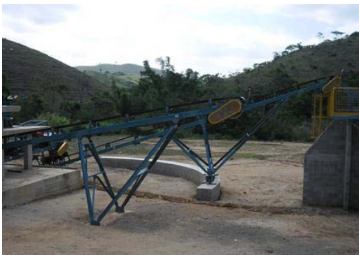
Vista da esteira móvel e a fixa. Fonte: Consórcio N/I. Relatório nov/2012.
