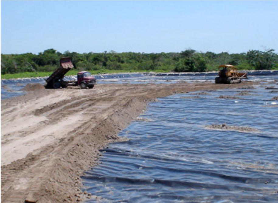
Figura 2 - Construção do sistema de impermeabilização
