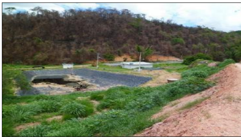
Figura 29 – Estação de tratamento de lixiviado (ETC) do vazadouro. Fonte: INEA, 2009.
