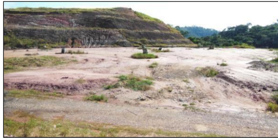
Figura 36 - Imagem do solo e processos erosivos (vistoria em maio de 2016). Fonte: Próprio autor.
