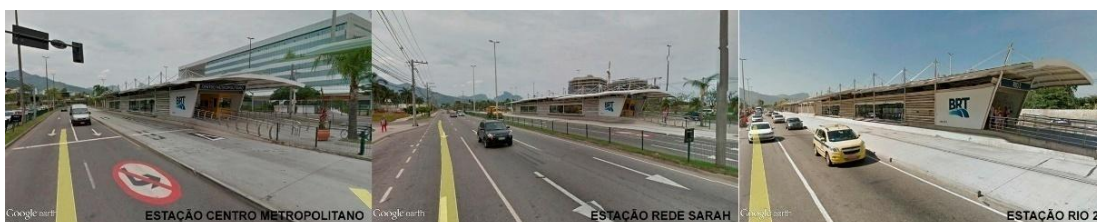
Figura 5.13: Estações do BRT Transcarioca Fonte: Imagem elaborada pela a autora a partir do Google Earth.
