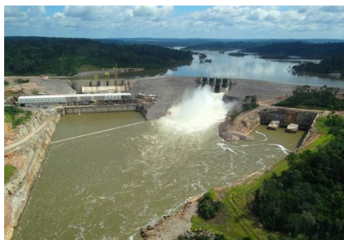
Foto 4 - Operação da UHE Teles Pires. Fonte: Companhia Hidrelétrica Teles Pires S/A (2016).
