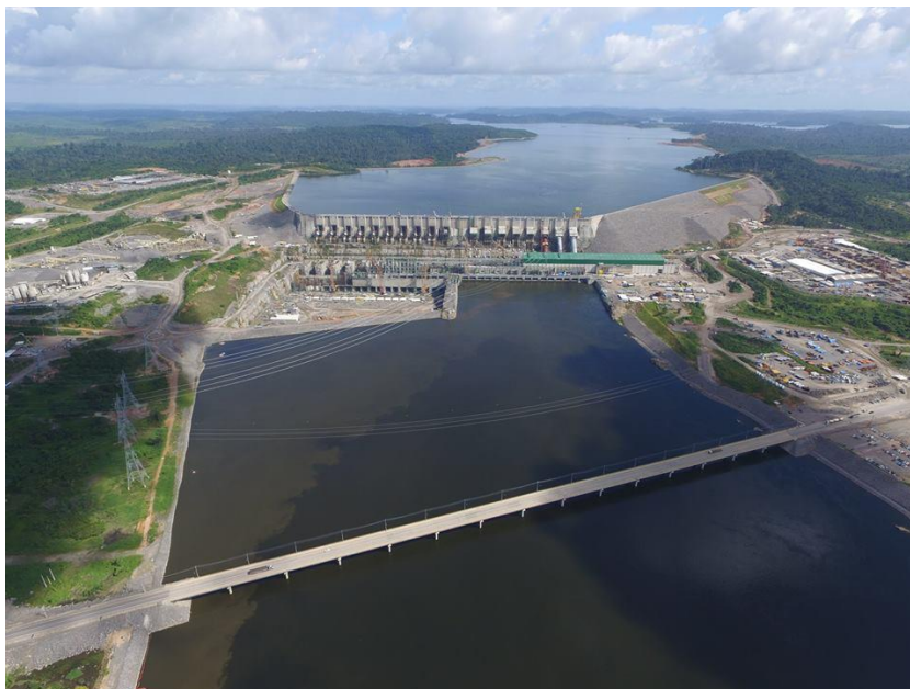
Foto 5 - Operação da UHE Belo Monte. Fonte: Norte Energia S/A (2016).
