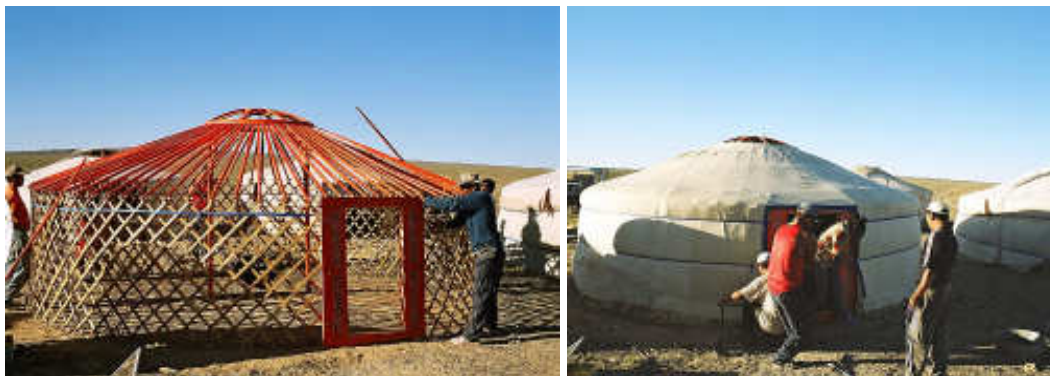
Figura 18: Montagem de um yurt Mongol. (Fonte: Wikipedia. Autor: Desconhecido, 2012)
