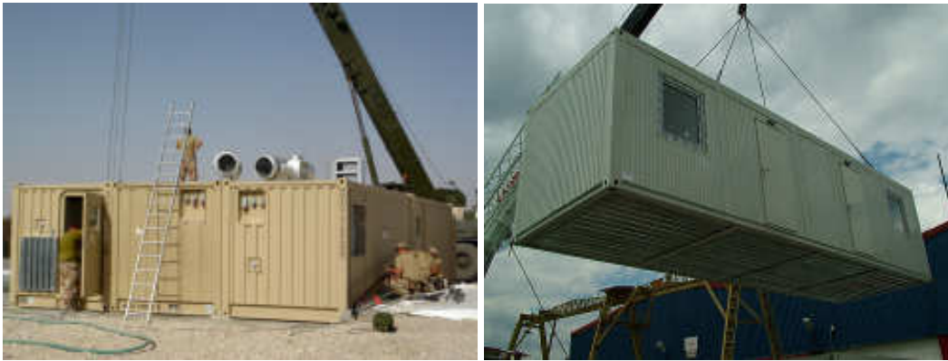
Figura 45: Módulo. A) Abrigos containeres da ISAF; B) Treysan (Fonte: Army Technology, 2012)
