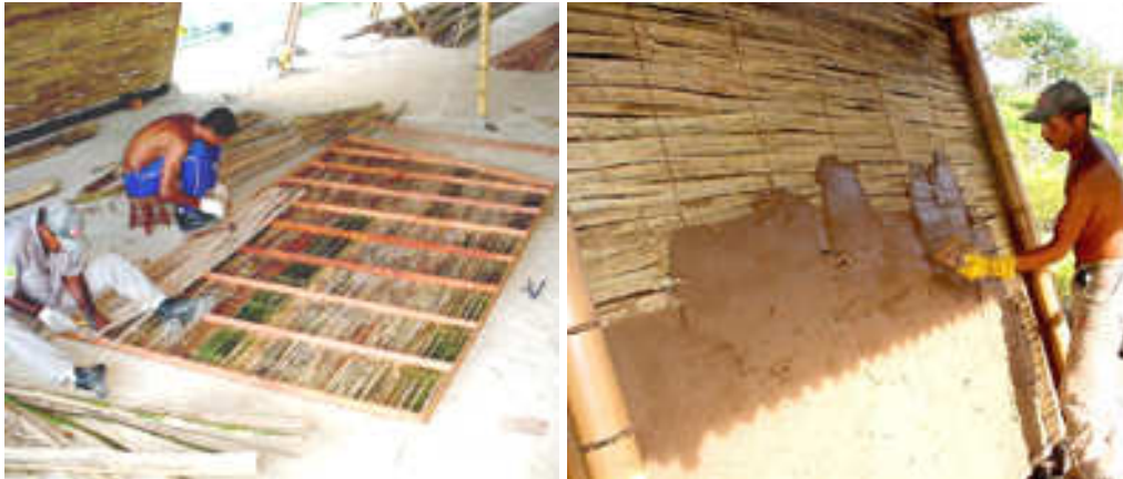
Figura 56: A) Montagem do painel em quadro de madeira de ripa comercial; e B) Aplicação de argamassa (Fonte: Nunes, 2005).
