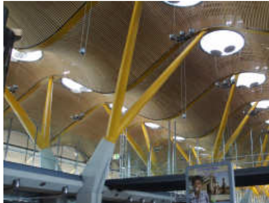
Figura 70: Forro de ripas de bambu no Aeroporto de Barajas, Madri, Espanha, 2010
