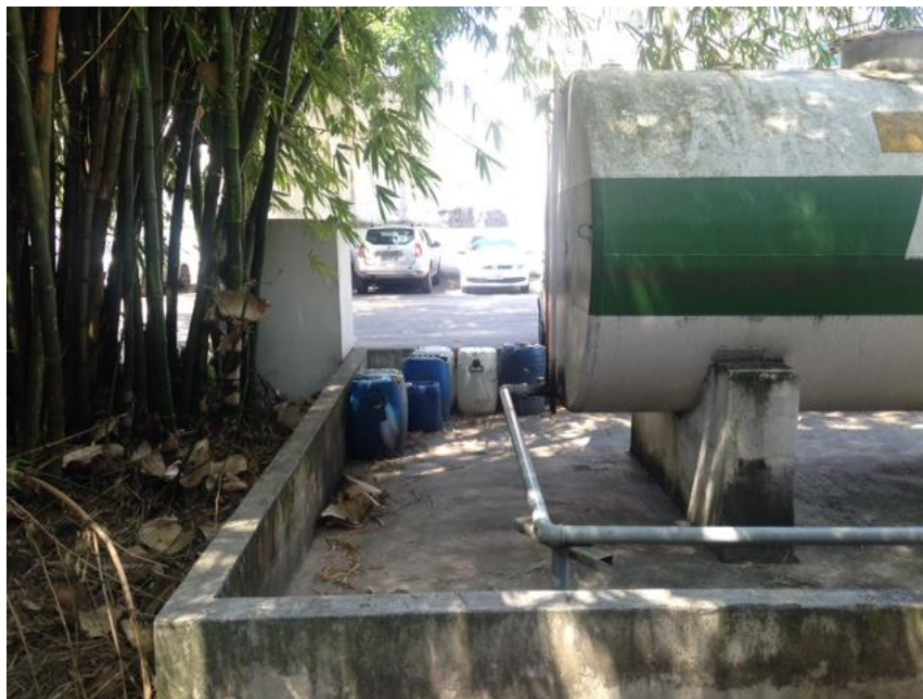
Figura 21: Resíduo Classe I acondicionado em local inapropriado
