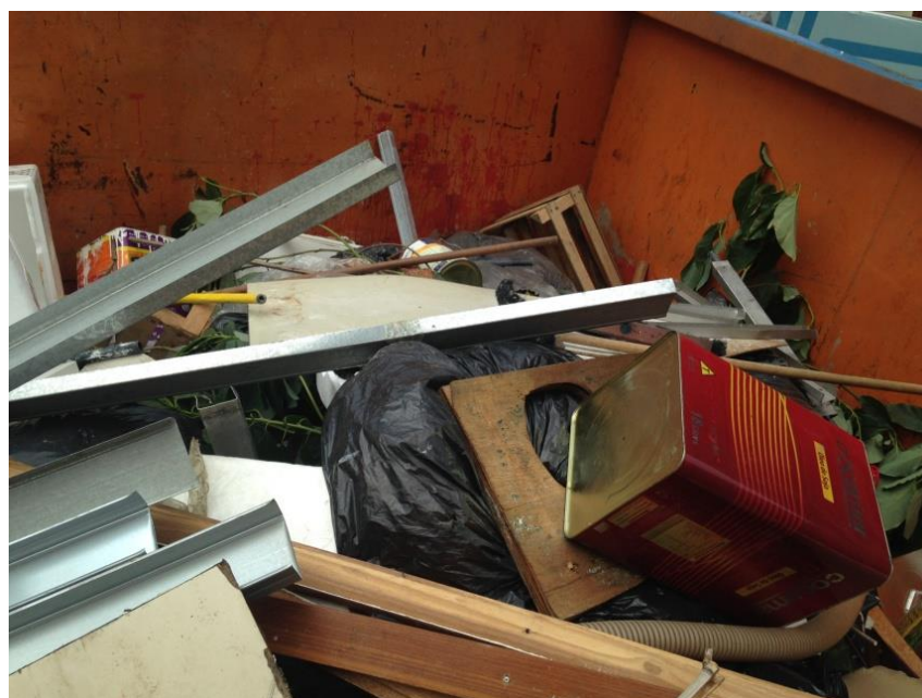
Figura 13: Sucatas ferrosas e madeira descartadas na caçamba de resíduo heterogêneo não compactável.
