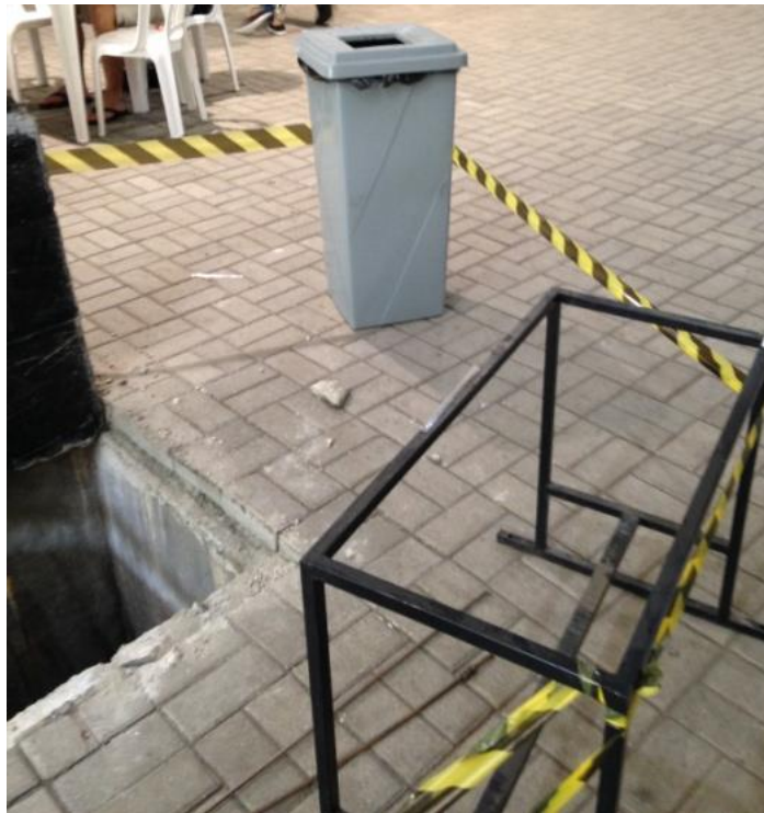
Figura 30: Coletor e suporte sendo usados durante uma obra de reparo, no pilotis do Ed. Leme.
