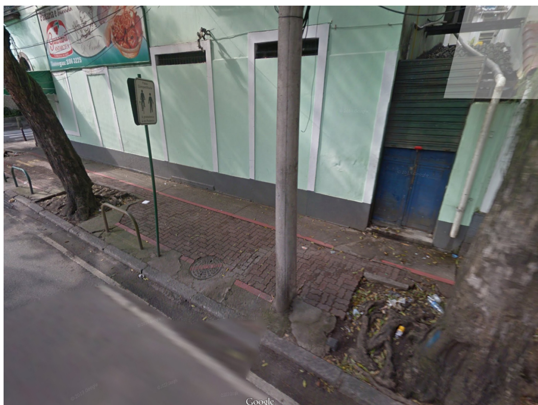
Figura 28 - Situação precária da ciclovia de Botafogo. Fonte: Google.
