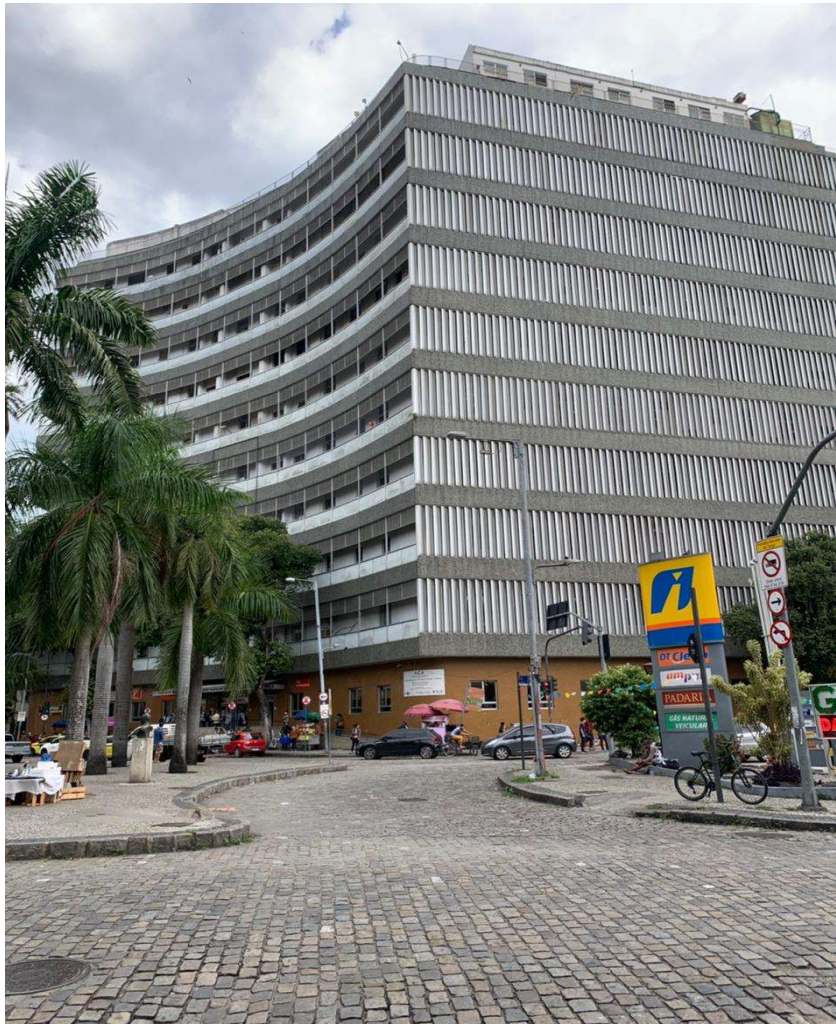
Figura 22: Prédio do INCA, HC I, Rio de Janeiro.
