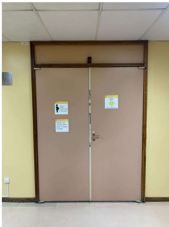
Figura31: Porta sala de tomografia – sinalização gestante.
