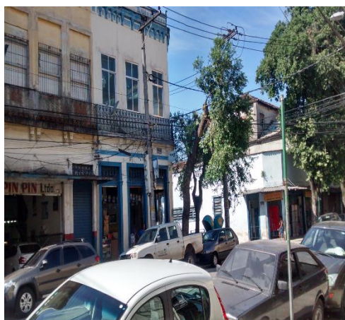
Figura 3.1 – Edificações típicas do bairro Fonte: Autor
