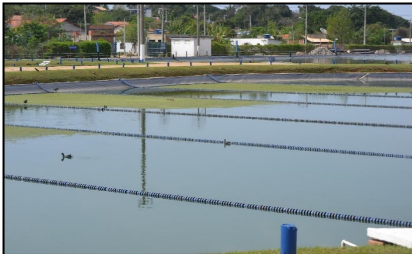
Figura 29: Lagoa de sedimentação. Fonte: Foto da Adriana Curty, 26 de outubro de 2017.
