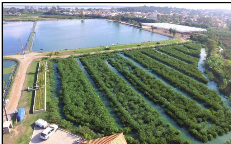
Figura 20: Vista em perspectiva da ETE Ponte dos Leites. Fonte: Concessionária Águas de Juturnaíba.
