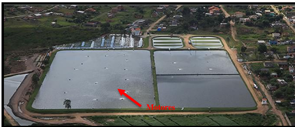
Figura 23: Vista aérea das lagoas da ETE Ponte dos Leites. Fonte: Vista aérea da ETE. 25
