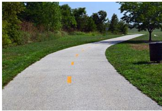
Figura 10 – Acesso em concreto permeável
