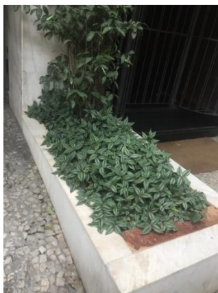
Figura 15: Edifício Paraíso – Canteiro com cobertura vegetal
