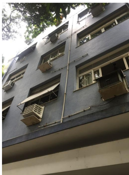
Figura 43: Edifício Paraíso – Detalhe do revestimento da fachada
