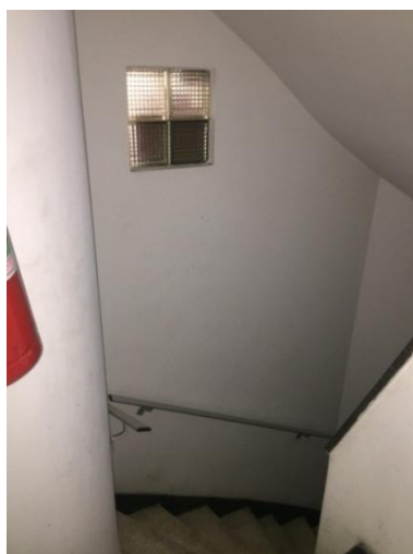
Figura 37: Edifício Paraíso – Janela localizada na área da escada
