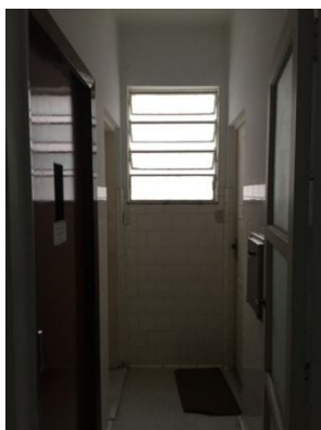
Figura 33: Edifício Paraíso – Iluminação natural do corredor de apartamentos Fonte: Autora.
