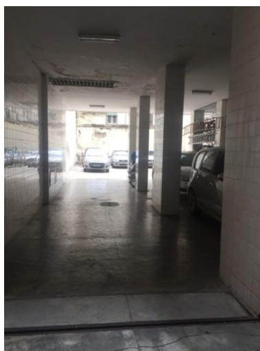
Figura 26: Edifício Paraíso – Garagem
