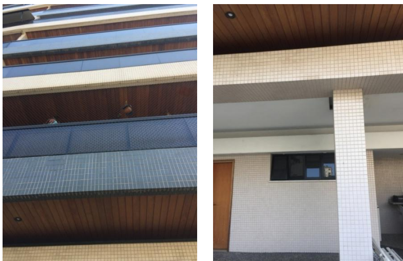
Figura 44: Condomínio Fleurville – Detalhe do revestimento da fachada
