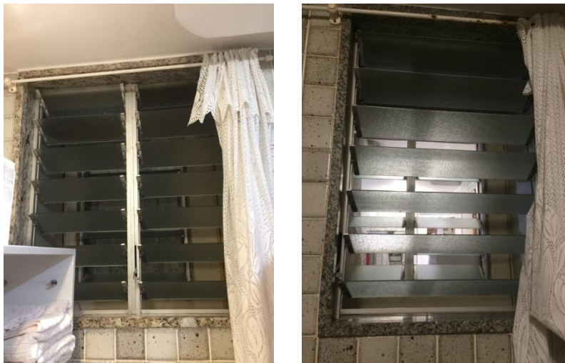
Figura 39: Edifício Paraíso – Janelas localizadas nos banheiros das unidades Fonte: Autora.
