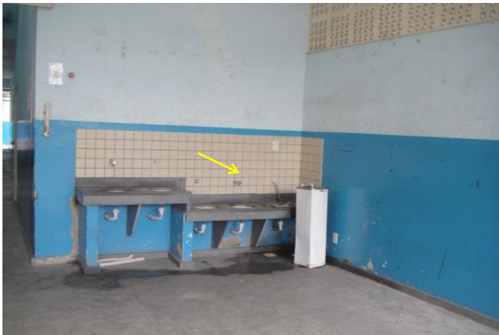
Foto 9- Instalação adaptada do bebedouro na área de recreação da escola A. Fonte: Registro da pesquisadora, 2017.
