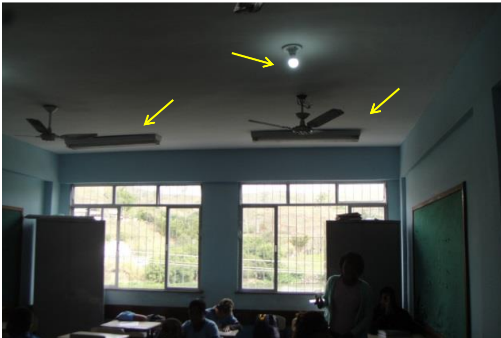
Foto 17- Substituição do tipo de luminária em uma sala de aula da escola A. Fonte: Registro da pesquisadora, 2017.
