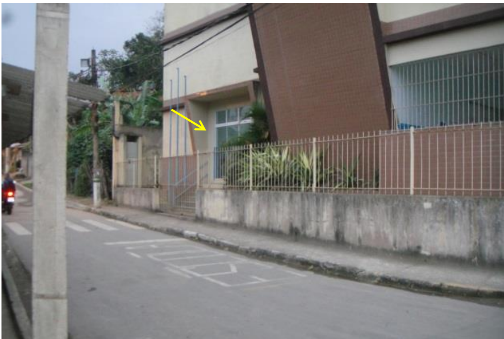
Foto 4- Entrada principal da escola B, com porta de vidro. Fonte: Registro da pesquisadora, 2017.
