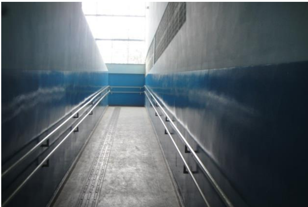
Foto 1- Rampa da escola A. Fonte: Registro da pesquisadora, 2017.
