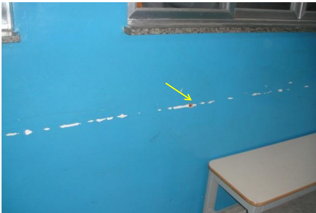
Foto 18- Parede e detalhe da alvenaria aparentemente sem emboço da escola B. Fonte: Registro da pesquisadora, 2017.
