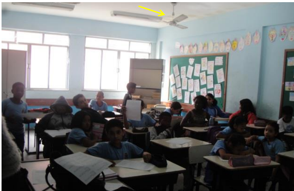
Foto 16- Ventilador preso pelo próprio fio em uma sala de aula da escola A. Fonte: Registro da pesquisadora, 2017.
